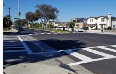
Plaza Del Amo and Cabrillo Ave – After
